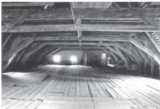
Les combles du Grenier de 1527 avec sa charpente d'origine (un des ouvrages de charpenterie les plus remarquables du Canton), état en 1992, et état actuel.
